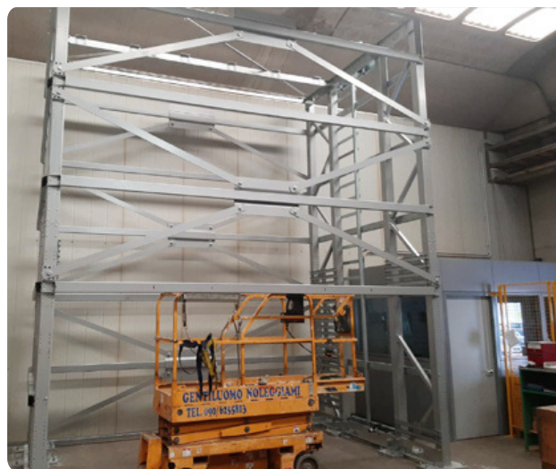
STRUTTURA ANTISISMICA RINFORZATA
